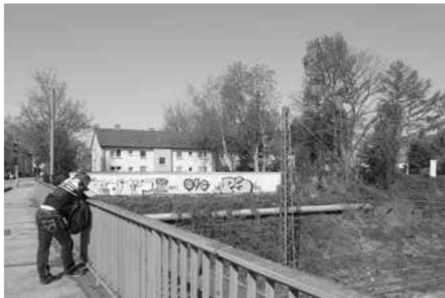
Eisenbahnbrücke am Oerweg Ein Wegpunkt, wo man Graffiti von verschiedenen Gruppen sieht. Trotzdem gehören alle zu einer Familie.
