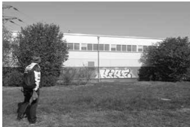
Umspannwerk am Oerweg An diesem Treffpunkt sollte ich meine Sachen zurückbekommen. Aber wir haben uns verpasst.
